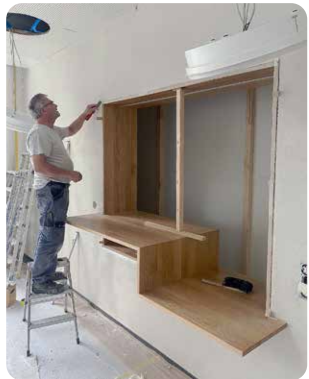
Der Umbau ist in vollem Gange.
