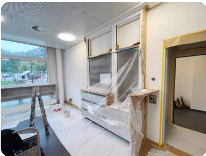
Der Umbau ist in vollem Gange.
